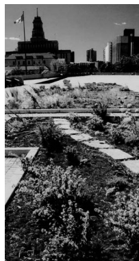
Le projet de démonstration de toits verts de l'hôtel de Ville de Toronto présente huit parcelles d'essai où figurent différentes applications de toit vert.
