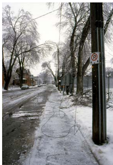
Une avenue résidentielle après une tempête de verglas à Ottawa. Les tempêtes de verglas peuvent dévaster une collectivité en faisant tomber les lignes électriques et en endommageant la végétation.
