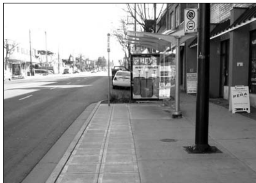
Figure 3-11 : Remarquez le puisard de rue près de l'avancée de trottoir.
