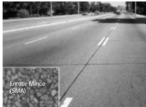
Photo 4-4 : Revêtement composite de route municipale reconstruit, avec couche de roulement en enrobé mince (SMA)
