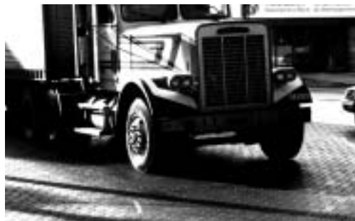
Photo 4-6 : Pavés de béton autobloquants utilisés pour reconstruire une rue municipale
