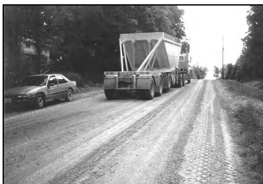
a) Mise en place de matériau granulaire supplémentaire par-dessus le vieux revêtement préalablement pulvérisé.
