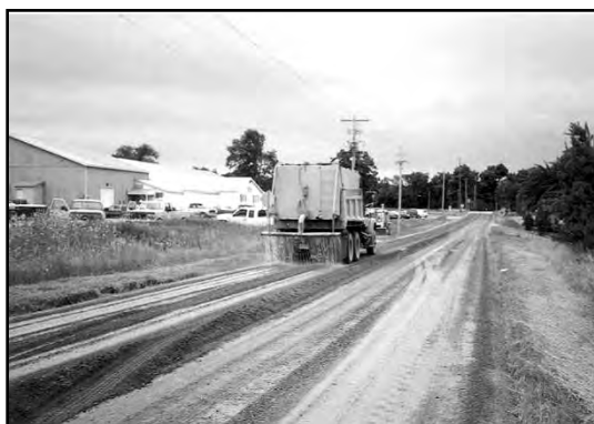
c) Mise en forme du matériau stabilisé et ajout d'eau en vue d'obtenir la condition d'humidité optimale pour le compactage.
