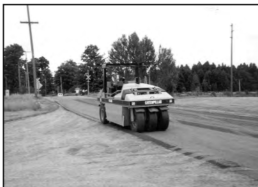
d) Compactage initial avec rouleau à pneus lourd suivi d'un rouleau vibreur en acier.
