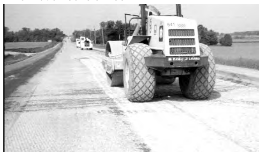
c) Compactage à faible amplitude du BCP fracturé, à l'aide d'un compacteur à rouleaux en acier.
