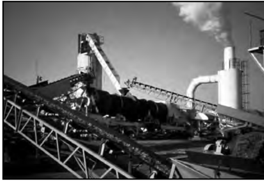
Photo 3-1 : Poste d'enrobage type à fournée, à débits parallèles.
