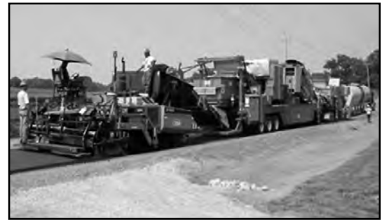
Photo 3-7 : Chaîne au bitume moussé de recyclage de couche de surface posée au finisseur.
