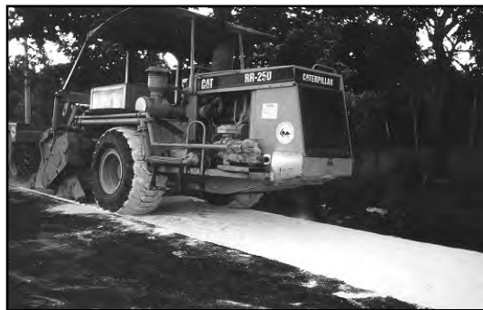
Photo 3-8 : Valorisation intégrale avec stabilisation à la chaux.
