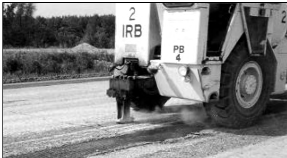
Photo 3-10 : Concasseurs à résonance en opération dans le comté d'Oxford, en Ontario.
