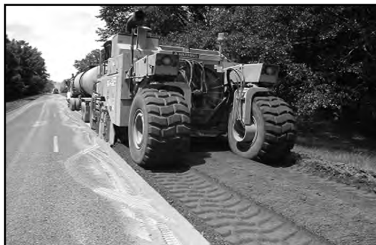
Photo 3-9 : Valorisation intégrale avec stabilisation au ciment
