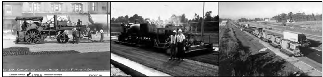
Photo A-9 : Recyclage à chaud et l'équipement utilisé dans le passé et le présent.
