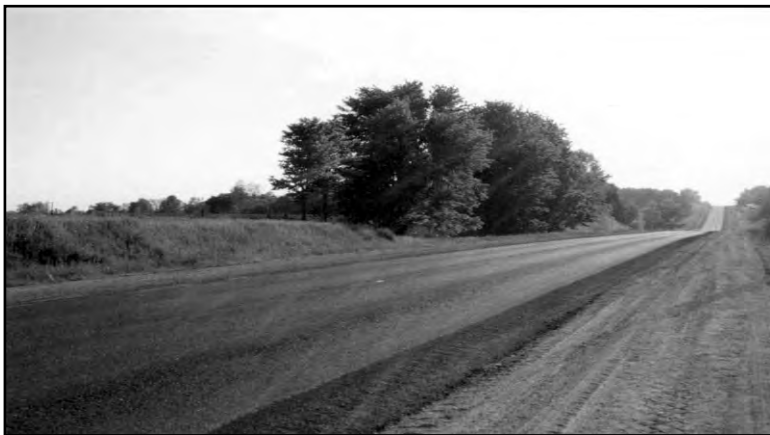
Photo A-3 : Vue du projet de la route 2 du comté d'Oxford après la fin des travaux.
