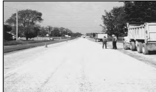
d) Aspect après compactage de la route 2 du comté d'Oxford.
