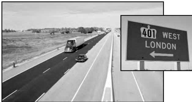
Photo A-10 : Le tronçon utilisé pour l'essai du procédé de recyclage à chaud entre Woodstock et London.
