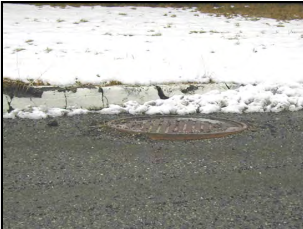
Photographie 2-4 : Légers problèmes de soulèvement dû au gel, et un certain arrachement.
