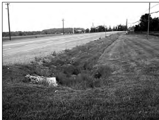
Figure A-5 : Fossé en bordure de la route pour remplacer le système de bordure et de caniveau traditionnel.
