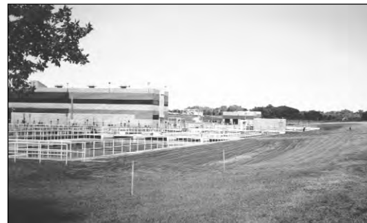
Figure A-6 : Rigole gazonnée servant au traitement et à l'adduction de l'eau.
