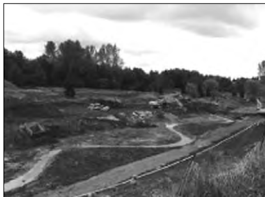
Figure A-2 : Restauration du méandre d'un cours d'eau.
