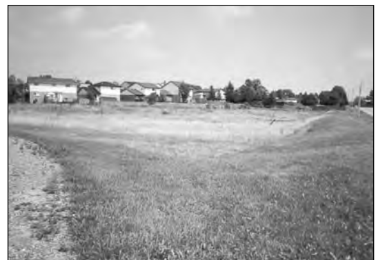
Figure A-12 : Étang sec destiné à contrôler la qualité de l'eau.
