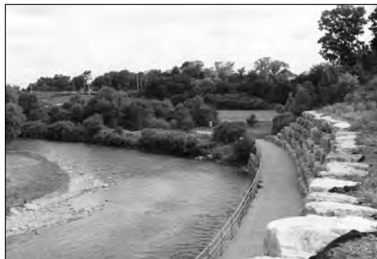
Figure A-4 : Protection des berges avec de la pierre de carapace.
