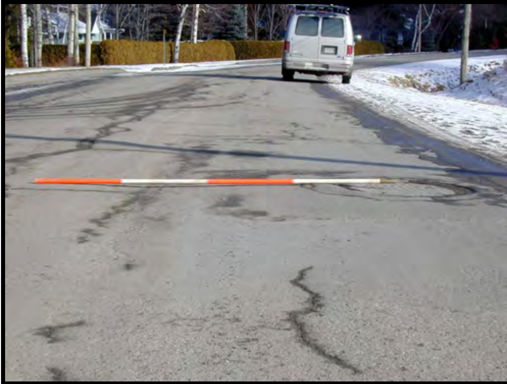
Photographie 2-3 : Soulèvement différentiel.
