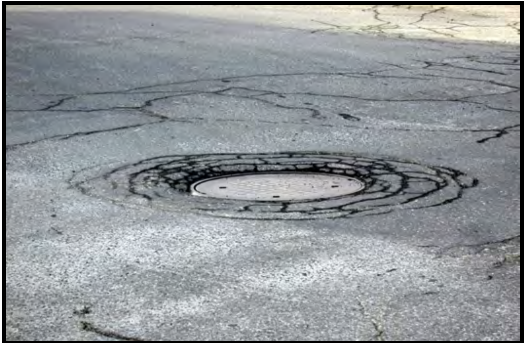
Photographie 2-2 : Fissuration concentrique.
