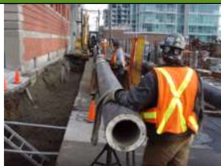
Ajout d'une conduite au réseau de la LEC. Source : Ville de North Vancouver.
