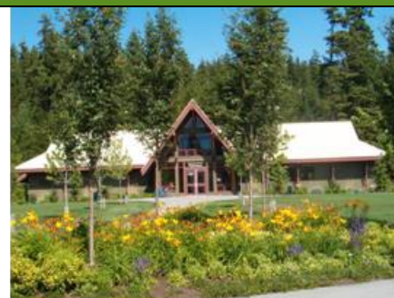
Ci-dessus : le complexe sportif de Spruce Grove. À gauche : la pompe géothermique. Avec l'autorisation de Whistler.
