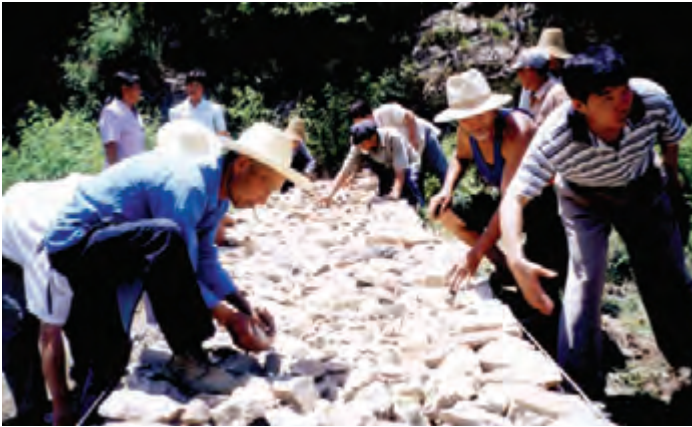
La construction d'une structure de contrôle d'érosion par les villageois, les fermiers et les autorités locales.
